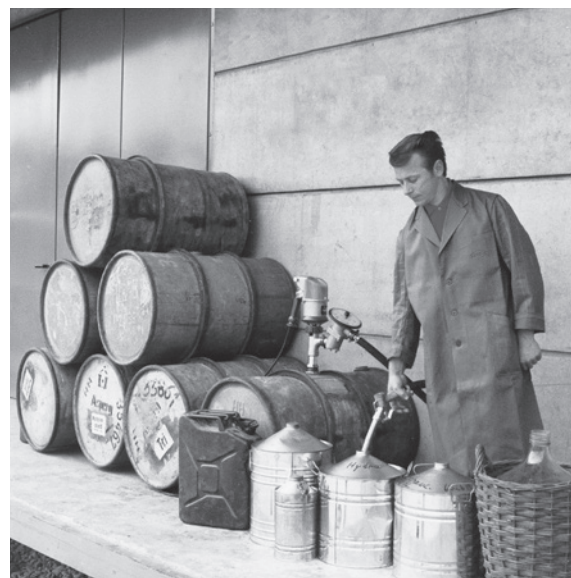
Manuelle Abfüllung mit Fasspumpe und FM Ringkolbenzähler im Jahr 1960.
